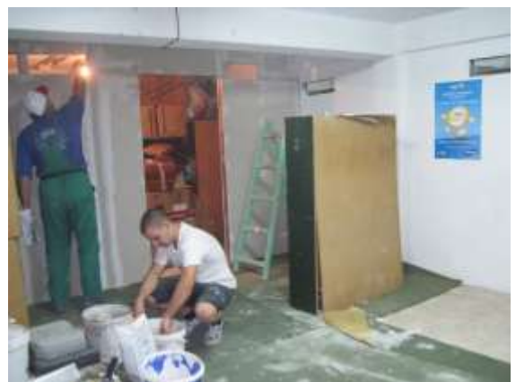
Die Vorbereitungsarbeiten zur Einrichtung des neuen Vereinsprojektes, eine Holzwerkstatt im Heim „Maria Luisa“ haben bereits begonnen
